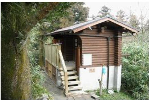
バイオトイレ全景
