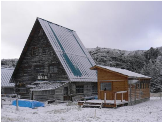
縞枯山荘（右側がトイレ棟）
