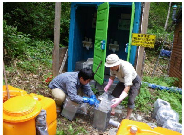
幌尻山荘の仮設トイレ汲取り作業の様子
