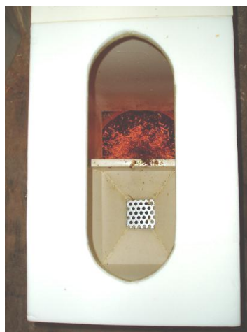
写真3 固液分離便器内部
