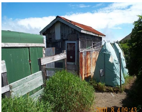
2011年当時 黒岳石室の旧トイレ棟
