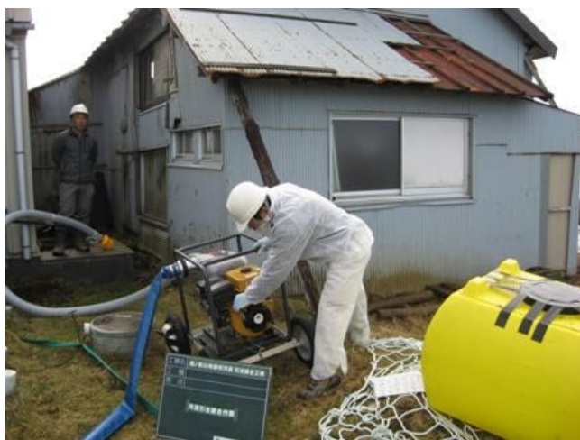
写真3 引き抜き作業。操作しているのがバキュームポンプ、右がローリータンク
