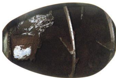
（写真１０）便槽にビニール袋（左側トイレ）
