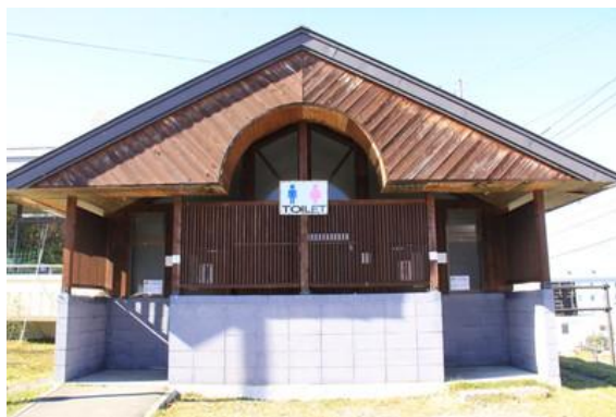
(写真5) 白金温泉・公衆トイレ
