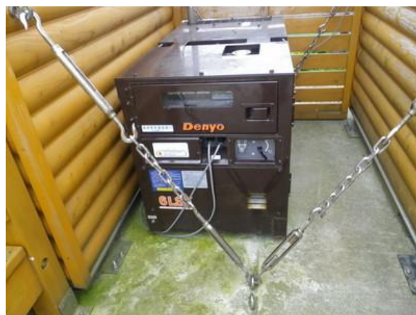
(写真5 1) 便槽熱源補給装置
