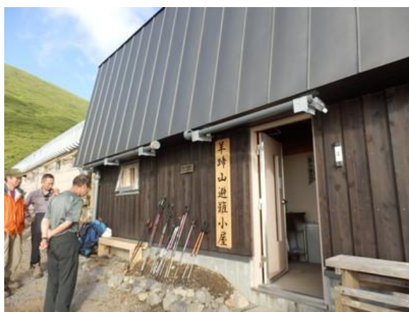
（写真1）避難小屋と玄関
