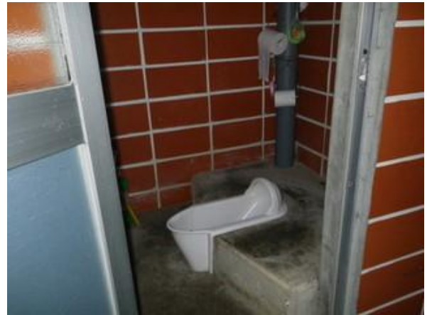
(写真6 5) トイレ内部
