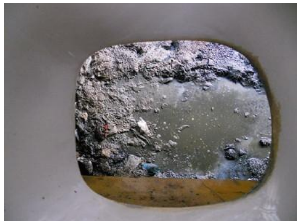
（写真28）便器から見た便槽。ゴミが殆どない
