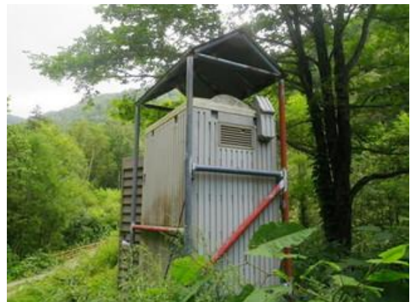
(写真51) 補強され屋根まであり
