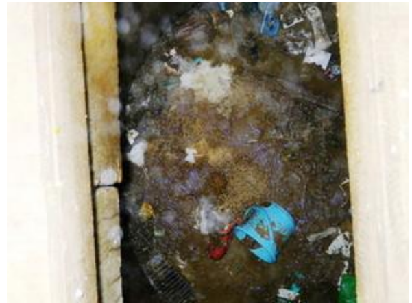
(写真4 5) 左側の便槽内
