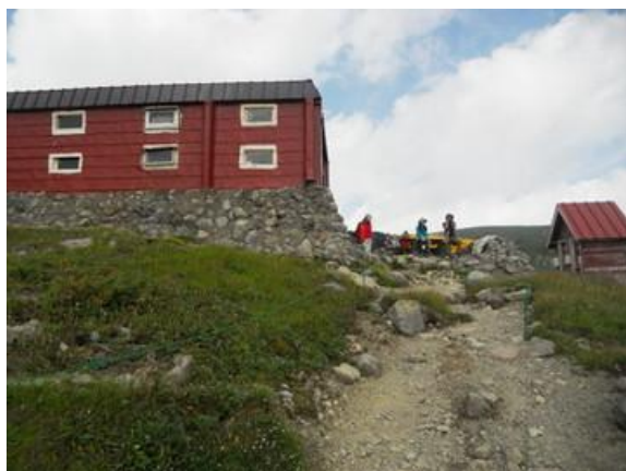
（写真23）板垣新道分岐から見た避難小屋とトイレ
