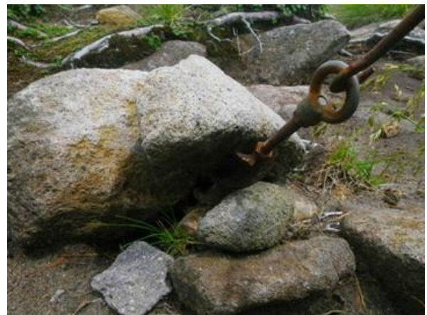
(写真16) 携帯トイレを支えるアンカー
