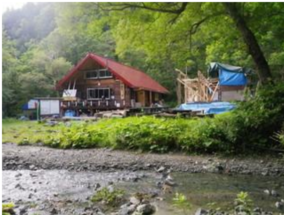
（写真5 6） ヒュッテ本館と建築中の炊事棟
