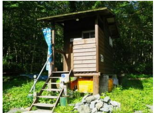
（写真5 7） 炊事棟の裏にあるトイレ
