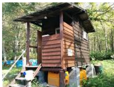
固液(糞尿)分離便器 左：洋式 中：和式 高床式トイレ棟 下に尿用タンクと糞用タンク
