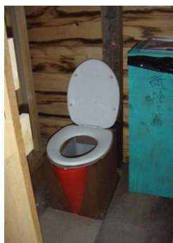
固液(糞尿)分離便器 左：洋式 中：和式 高床式トイレ棟 下に尿用タンクと糞用タンク
