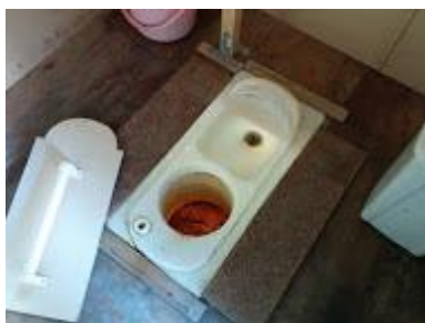
固液(糞尿)分離便器 左：洋式 中：和式 高床式トイレ棟 下に尿用タンクと糞用タンク
