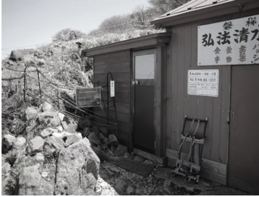
(写真) 弘法清水小屋に増設した携帯 トイレブース
