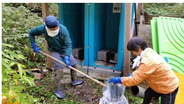
貯留式トイレからの排泄物の汲み取り作業
