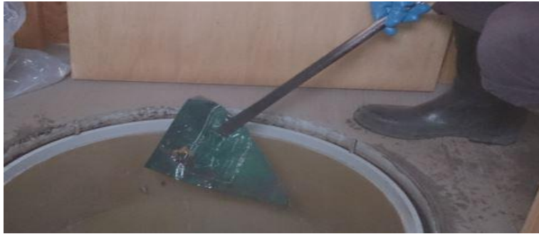
●写真3 消化槽第1室の異物混入（使用済み携帯トイレ）の除去作業
