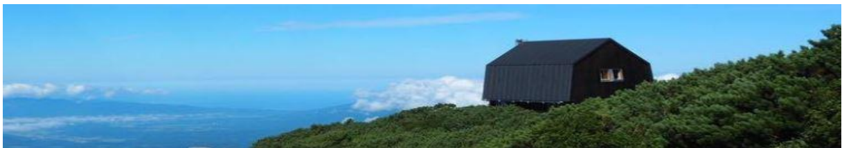
羊蹄山避難小屋全景
