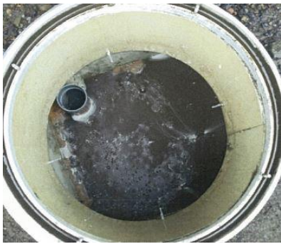
●写真4 消化槽第2室の状況
