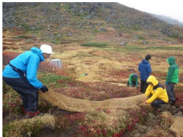
トイレ道の植生回復のためヤシネットを敷設 （写真提供：合同会社 北海道山岳整備）
