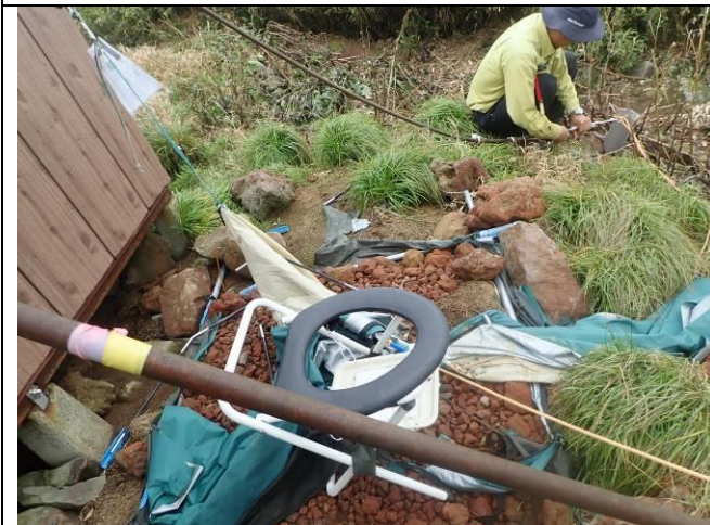
避難小屋のワイヤーのネジを締め直し
