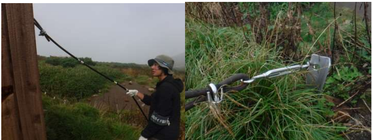
避難小屋を固定するロープは、4カ所とも意図的に緩みを持たせているようでした。アンカーは強固です。
