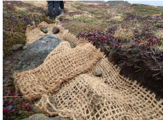
写真 12 ヤシネットによるマット施工
