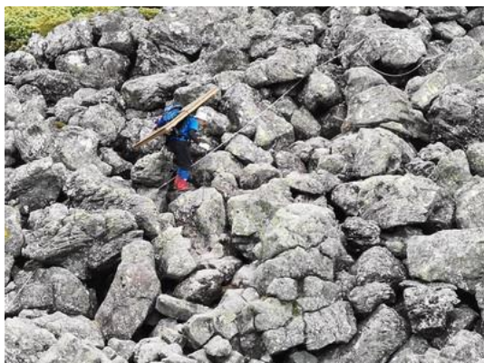
写真 7 資材荷揚げの様子
