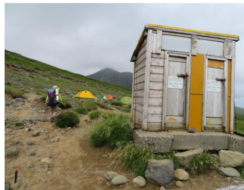
上ホロ避難小屋トイレ（2020年）
