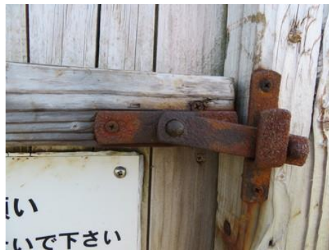
ドア外側の錆びた開閉鍵（2020年）
