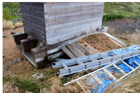
裏側・コルゲート便槽に蓋（2020年）
