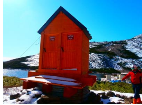
トイレは上屋だけ改修（2019年）
