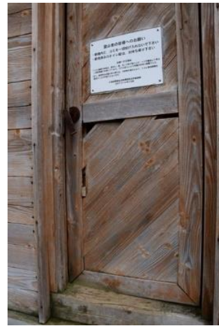
ドア板に隙間がある（2020年）
