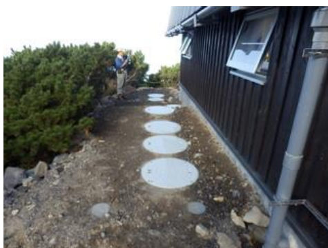
羊蹄山土壤処理・マンホール群
