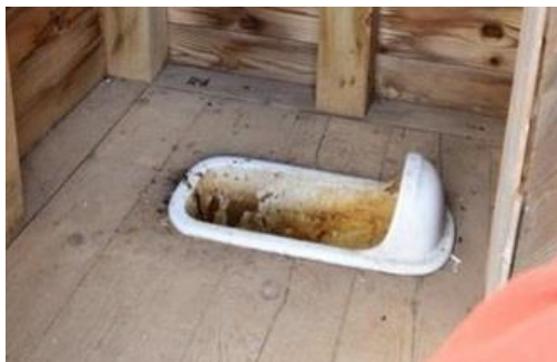
汚れた便器（2020年）
