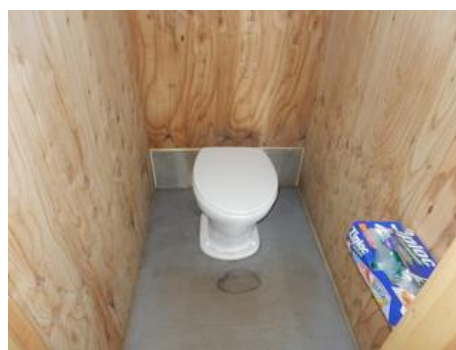
羊蹄山避難小屋トイレ
