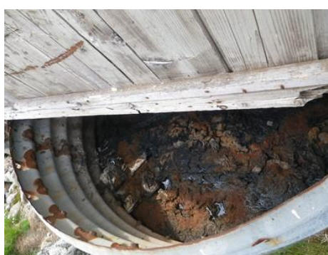
裏側のコルゲート管便槽 (2016年)
