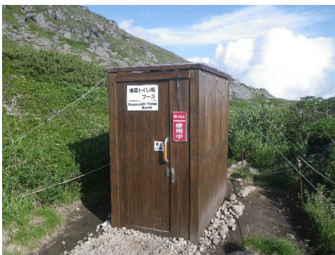
令和元年新設携帯トイレブース
