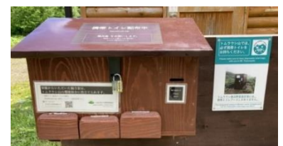
短縮路登山口のバイオトイレに設置
