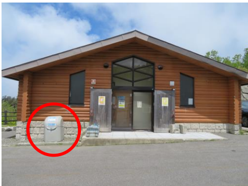
駐車場の公衆トイレ前に設置
