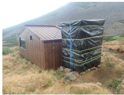
冬囲いされた携帯トイレブース
