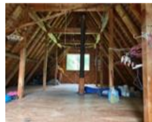
山荘2階内部 中央部にストーブ煙突が伸びる
