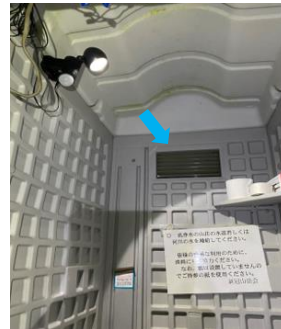
仮設トイレ 角型ガラリ換気口 (正面上部) 照明は太陽光発電式
