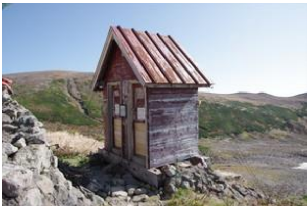
38年経過した白雲岳避難小屋トイレ
