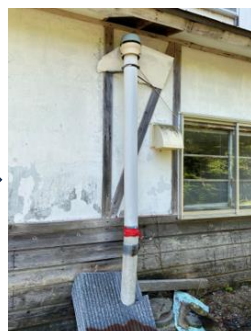
抜気筒（修繕後）6/25
