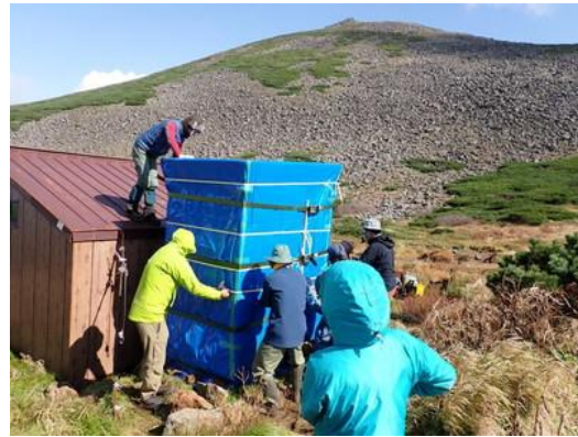
冬囲い中の携帯トイレブース
