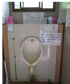
プレハブトイレ内部 (小便器) 排尿後は右下のペダルを踏むと水が流れる
