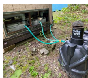
便槽で固液分離され、汚水は綠色ホースで右側黒色の貯留タンクへ流れるしくみ
