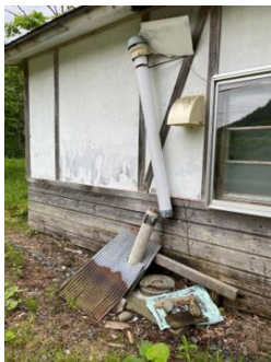
抜気筒（修繕前）6/24
