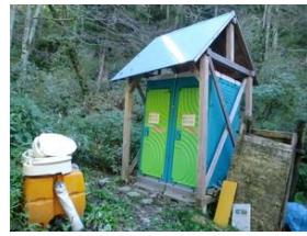
山荘屋外の携帯トイレブース
