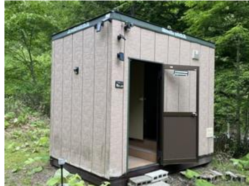
プレハブトイレ（前室がある）
