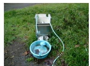
簡易水洗用の水 (沢より導水)
