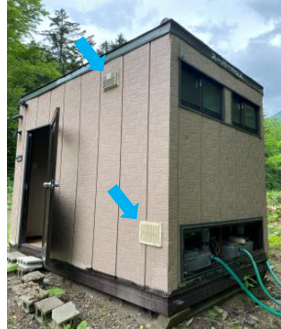
プレハブトイレ外観 角型ガラ リ換気口は各上下に位置(青矢 印)
