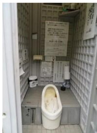
仮設トイレ内部 簡易水洗
