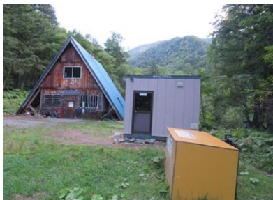
新冠ポロシリ山荘とプレハブトイレ、仮設トイレはプレハブの裏に隣接。手前は汚物集積箱
