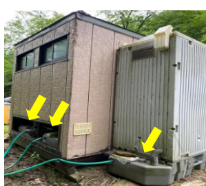
プレハブ及び簡易両トイレ裏側 糞尿と洗浄水は各トイレ真下の便槽に沈殿・貯留される(黄矢印)
