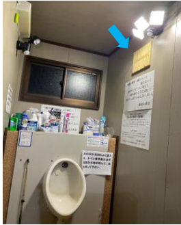
プレハブトイレ 開閉式換気口 (右上) 照明は太陽光発電式
