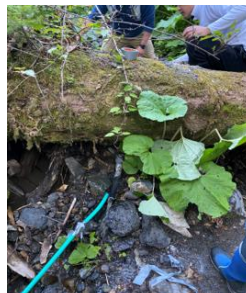
取水源から山荘へ伸びるパイプ
