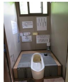
プレハブトイレ内部 (和式側) 排泄後は右上の凸部を踏むと水が流れる
