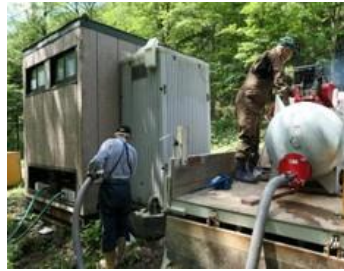
プレハブトイレ裏側とバキューム装置による汲み取り作業の様子
