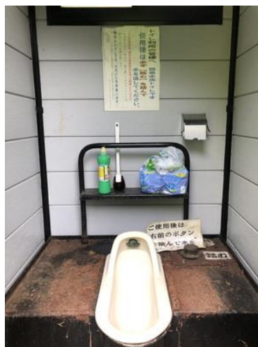
簡易水洗のトイレ
