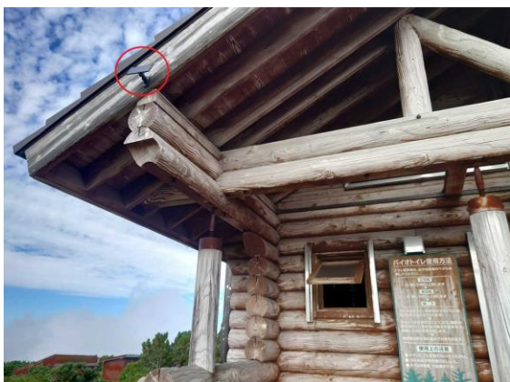
太陽光パネル
