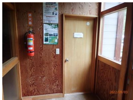
トイレ室のドア
