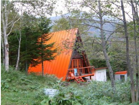
伏美小屋。右奥がトイレ
