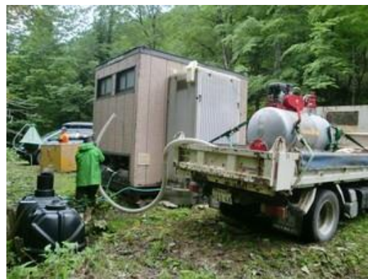
可搬型バキュームでの汲み取り作業
