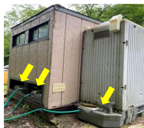
プレハブ及び簡易両トイレ裏側 糞尿と洗浄水は各トイレ真下の便槽に沈殿・貯留される (黄矢印)
