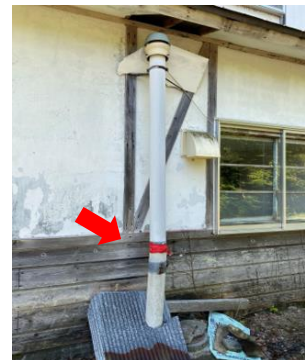
トイレ外側の便槽から延びる抜気筒 冬の雪害により筒が破損していたが、6/25に修繕済み。
