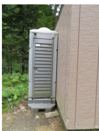
仮設トイレ正面
