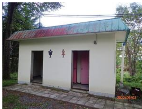
剣山山小屋の別棟トイレ
