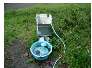
簡易水洗用の水 (沢より導水)
