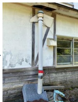
抜気筒（修繕後）6/25
