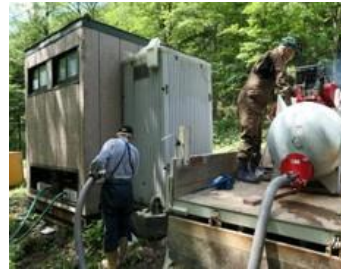
プレハブトイレ裏側とバキューム装置による汲み取り作業の様子
