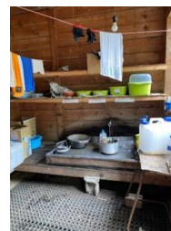
流し台 水は沢水を導水
