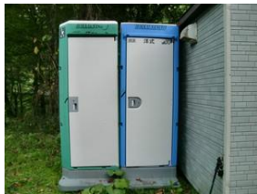
第二ゲートの仮設トイレ
