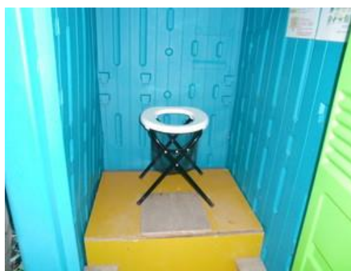
屋外仮設トイレを携帯トイレブースに改装
