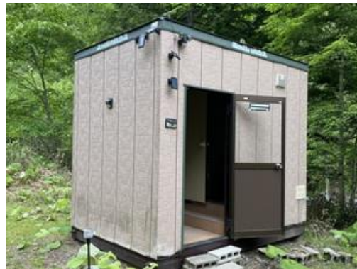
プレハブトイレ（前室がある）
