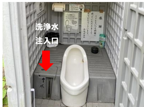
仮設トイレの和式便器 右前に黒いペダルがある
