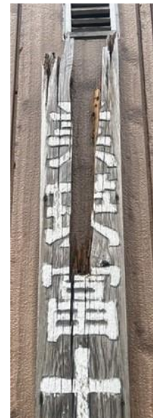
標識の破損
