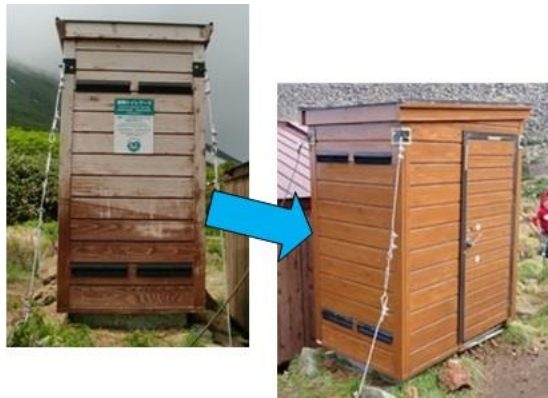
ブースの塗装を実施 (業者による)
