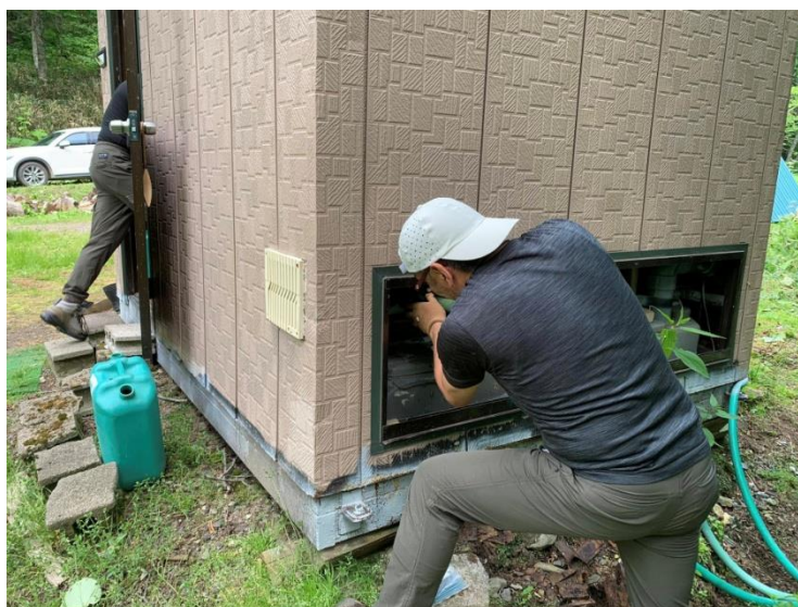
トイレの補修作業
