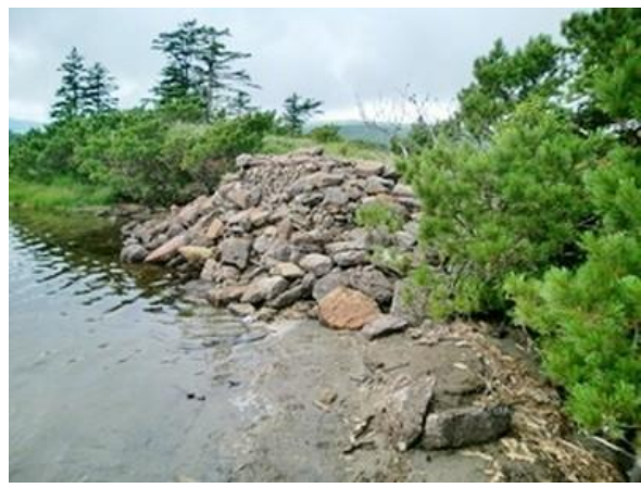
護岸工事の箇所。越えると木道
