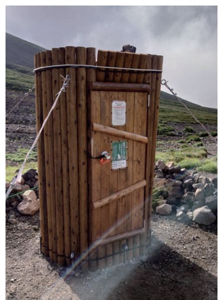
裏旭岳野営場トイレブース
