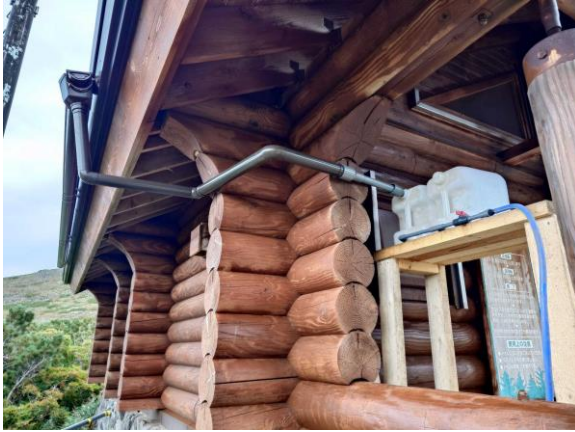
雨どいと水タンクの設置
