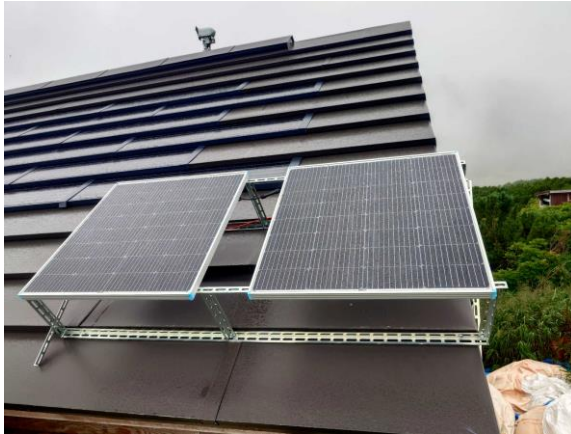
ソーラーパネル設置
