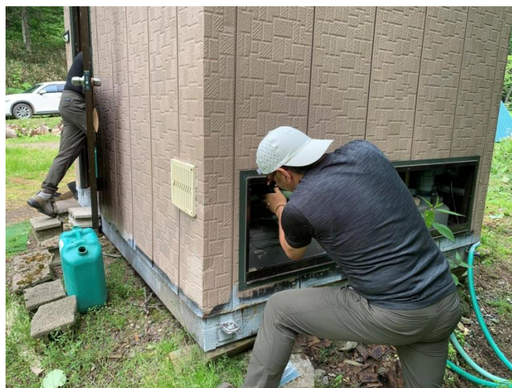
トイレの補修作業
