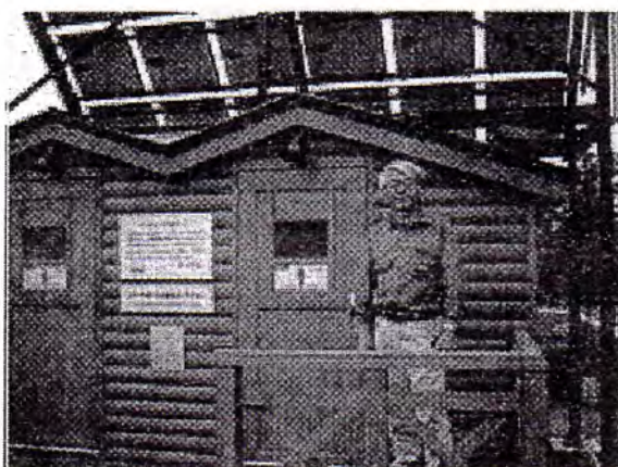
図4 ソーラーバイオトイレ外観（正面）
