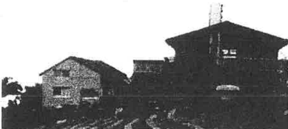
写真3 塔ノ岳公衆トイレ
