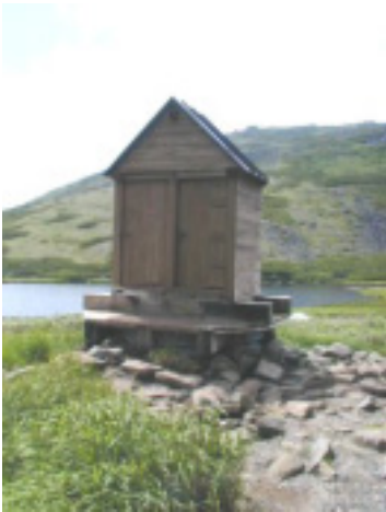
ヒサゴ沼避難小屋トイレ
