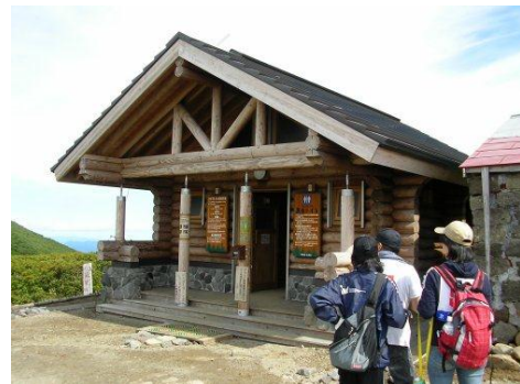
(写真－2)黒岳石室バイオトイレ
