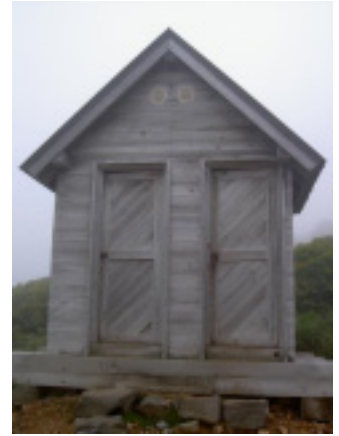
忠別岳避難小屋トイレ
