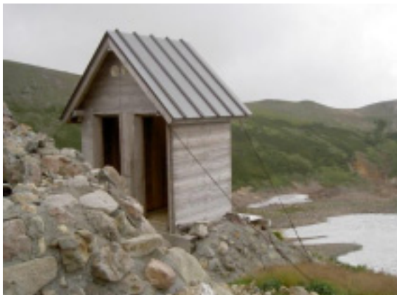
白雲岳避難小屋トイレ
