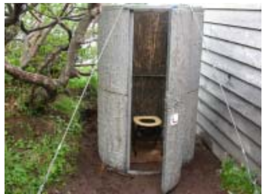
携帯トイレブース（避難小屋 樹脂製）
