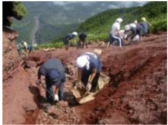
土のう積み階段設置作業
