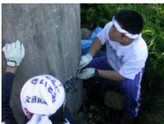
補修作業（蝶番取付）
