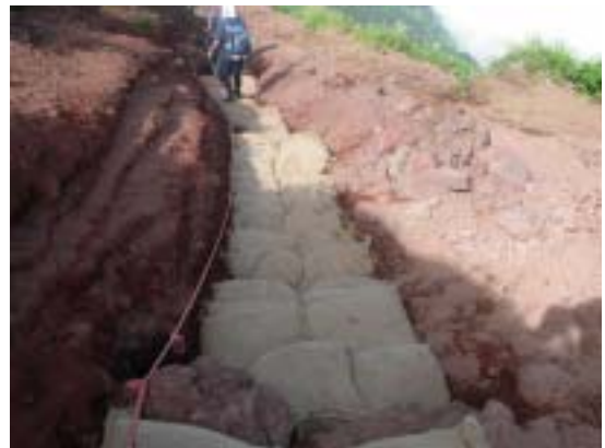
土のう積み階段（設置後）
