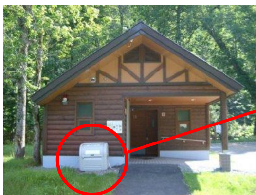
(写真－13) 東大雪荘前公衆トイレ
