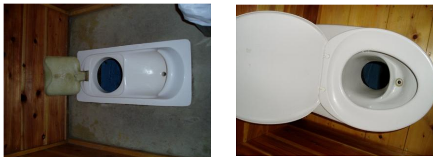
（写真－19）和式と洋式の固液分離便器（穂莉康治氏写真提供）
