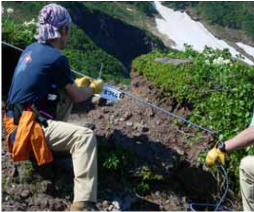
進入禁止ロープ付け替え作業
