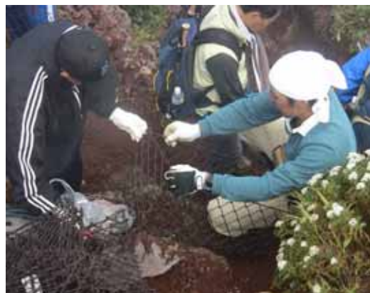
フトン籠階段設置作業
