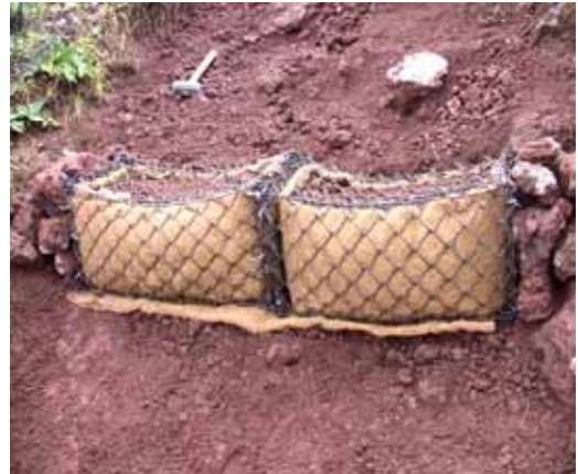
フトン籠階段（設置後）
