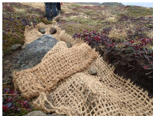
写真 12 ヤシネットによるマット施工
