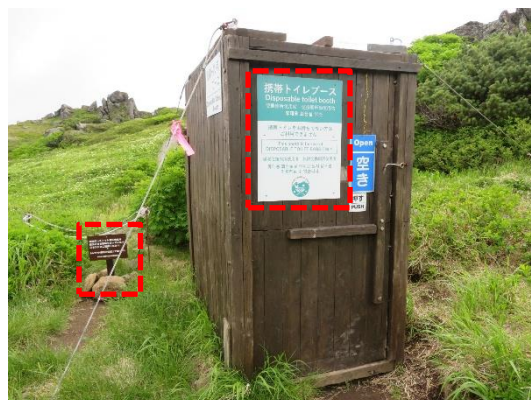
写真 5 携帯トイレブースと脇のトイレ道
