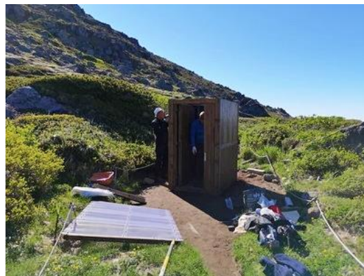
写真 8 ブース組み立て・設置の様子
