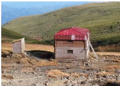
上ホロ避難小屋とトイレ（2020 年）
