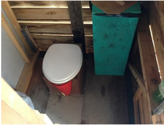
旧トイレの様式個室。壁材のみで寒々しい(2014 年)
