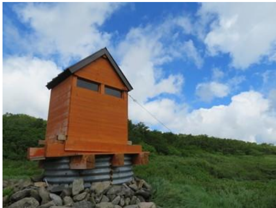
裏側・コルゲート便槽が見える（2019 年）
