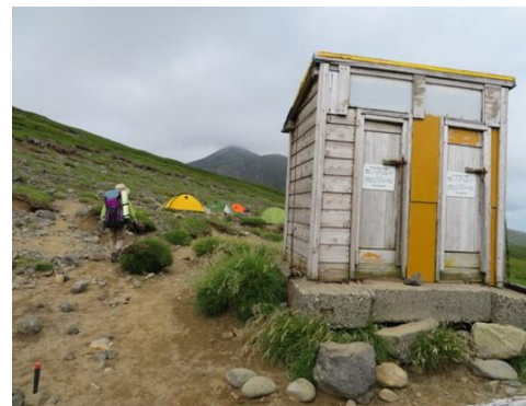
上ホロ避難小屋トイレ（2020 年）
