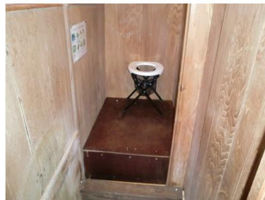
小屋内トイレも携帯トイレブースに改装
