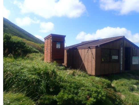
美瑛富士避難小屋横に設置された携帯トイレブース
