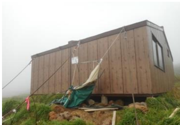
9月2日、台風でテント型トイレブースが倒壊
