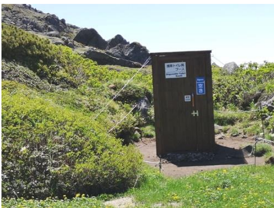
7月に設置された2基目の携帯トイレブース
