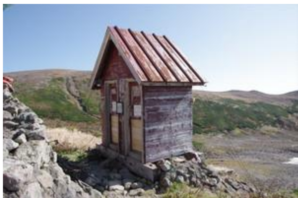
38年経過した白雲岳避難小屋トイレ
