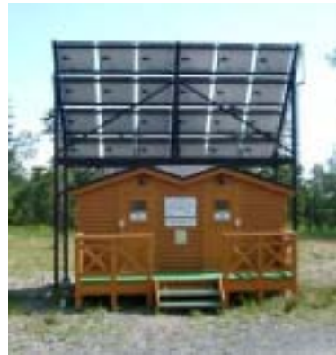
トムラウシ短縮路のバイオトイレ
