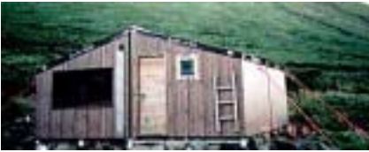
美瑛富士避難小屋 にはトイレが無い
