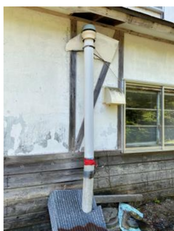
抜気筒（修繕後）6/25
