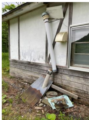
抜気筒（修繕前）6/24
