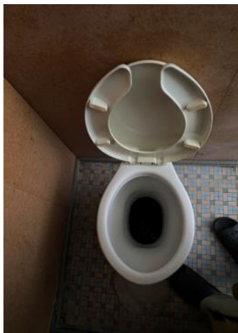
洋式便器 (拡大) 山岳会による清掃が行き届いている。また浄化槽シーディング剤による微生物分解の効果で臭いは殆ど感じられない。
