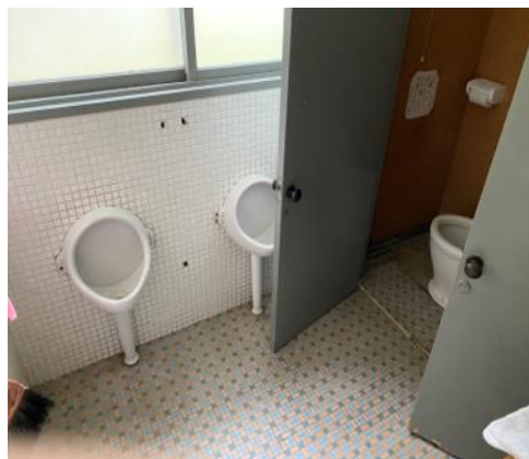
トイレ内部 小便器は2本 黄バミや尿石もなくきれいであった
