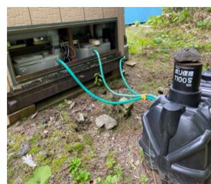
便槽で固液分離され、汚水は綠色ホースで右側黒色の貯留タンクへ流れるしくみ
