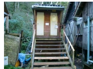
幌尻山荘のバイオトイレ
