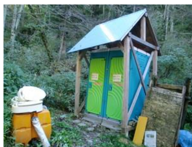
山荘屋外の携帯トイレブース
