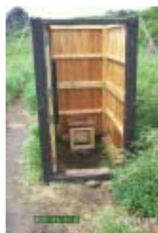
トムラ南沼の携帯トイレブース (ドアが開いたところ)
